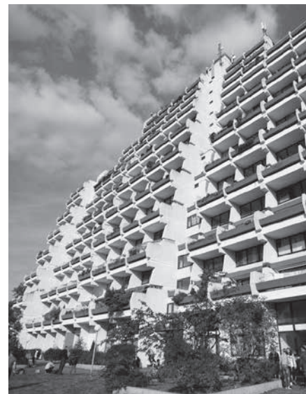
Das geräumte Gebäude „Hannibal II“ in Dorstfeld
