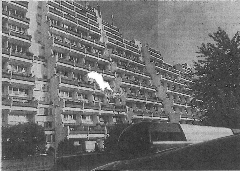
Eklatante Brandschutzmängel beklagt die Feuerwehr im Hannibal-Wohnkomplex in Dorstfeld. Deshalb wurde er komplett geräumt.
